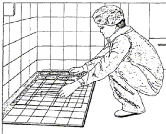
Рисунок 19 - Снятие шаблона
